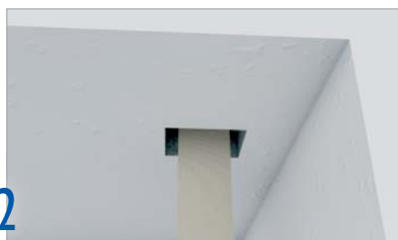
2 Aussparung für die Montage der Gurtführung anpassen (30 x 20 mm).
