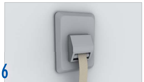
6 Abschließend Abdeckrahmen aufstecken.
